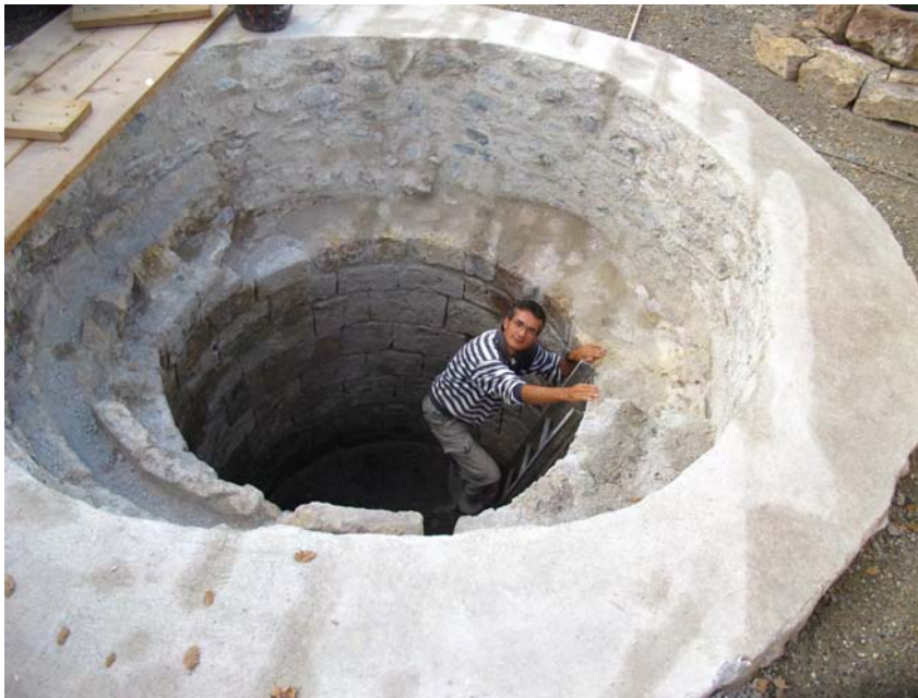
Fig.19 La citerne après consolidation du parement intérieure et remontage de la margelle.
