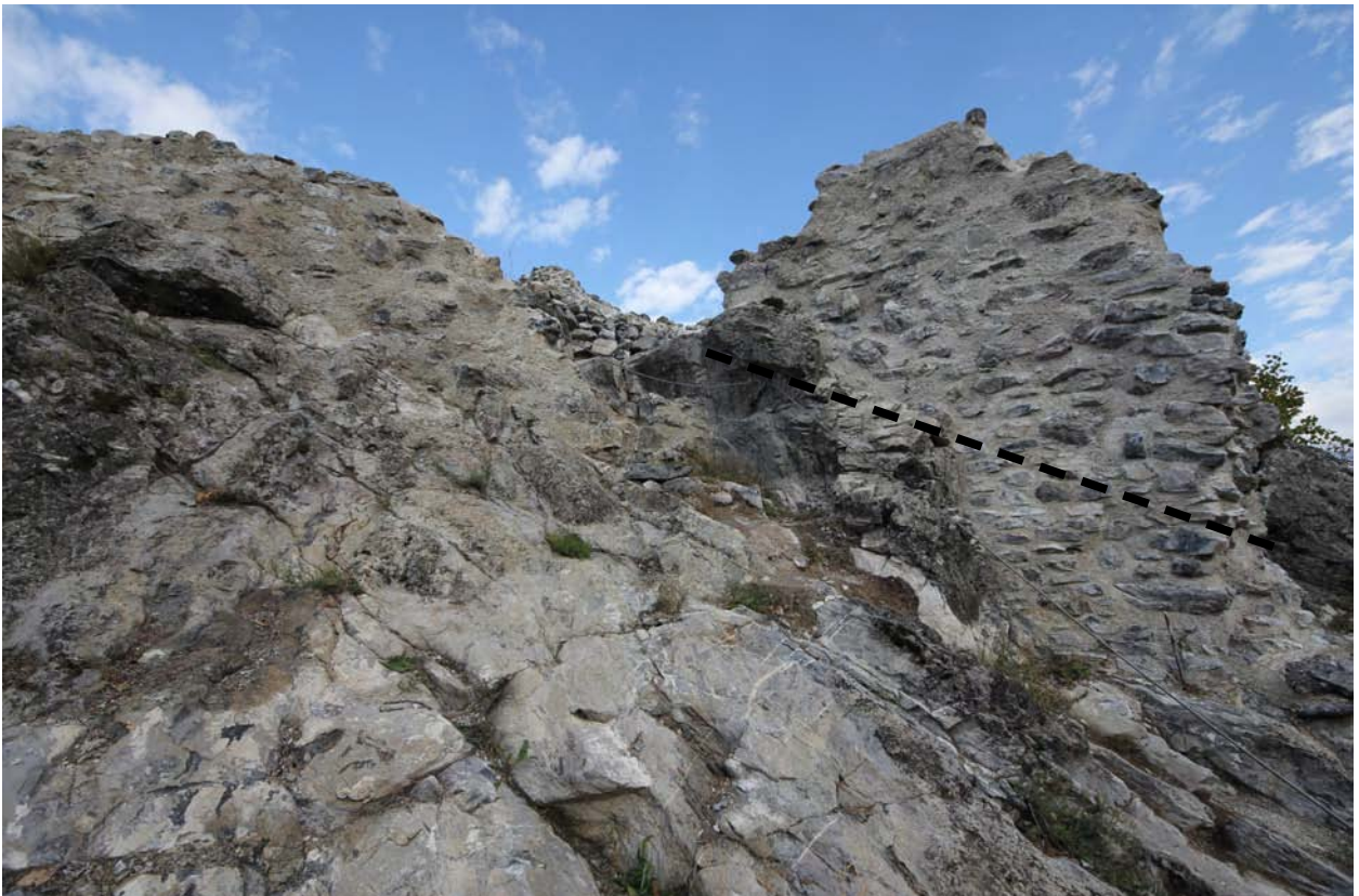
Fig. 3 Entaille oblique du rocher (inclinaison 47,5%) au sud de l'éperon (E) indiquant l'emplacement de la première volée d'escalier. Restitution d'un escalier de 13 marches de 0,25 m de hauteur et de 0,53 m de profondeur.
