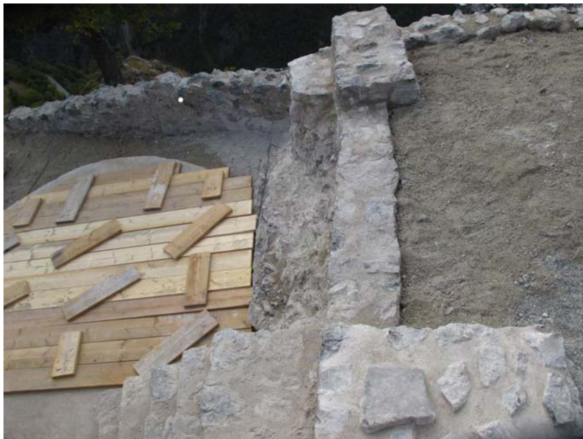
Fig.20 Couverture provisoire de la citerne.
