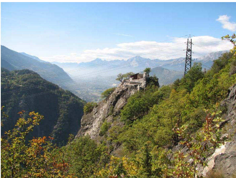
Fig.27 Vue depuis l'est à la fin des travaux 2011.
