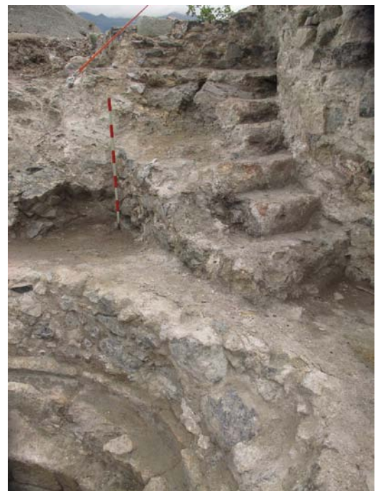
Fig.17 L'escalier conduisant à la terrasse supérieure avant sa consolidation.
