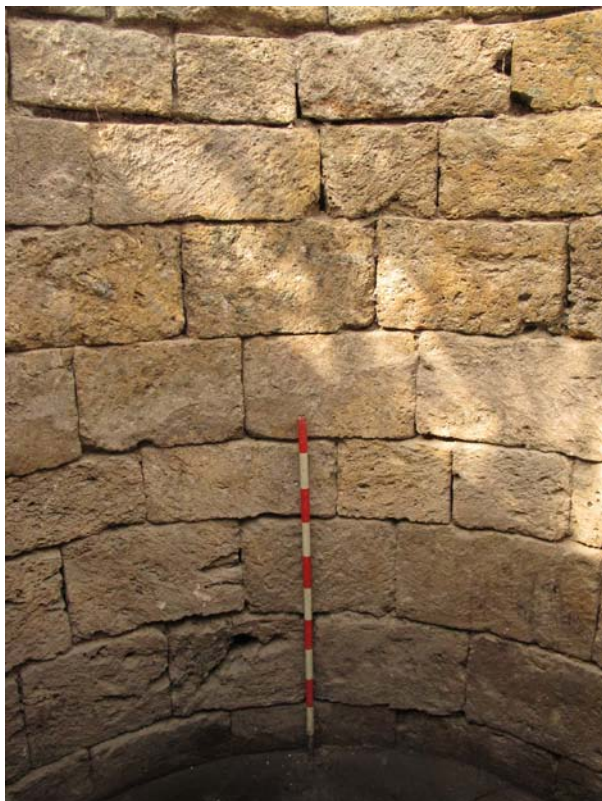
Fig. 7 Parement de la citerne en blocs de cagneule taillés. Une couche de limon argileux vert olivâtre dans et contre laquelle les blocs sont adossés assure l'étanchéité.
